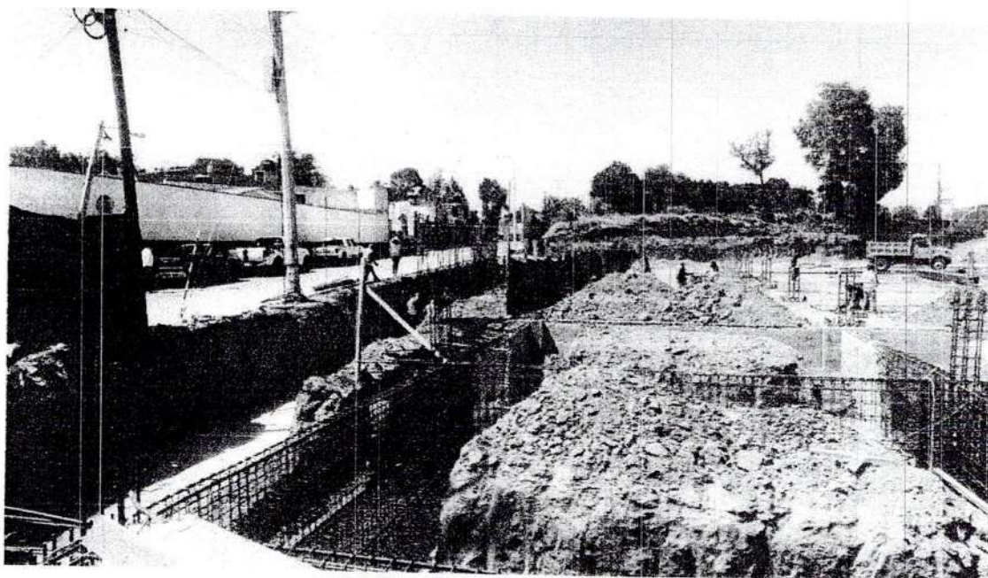
Armado de acero en cimentación
